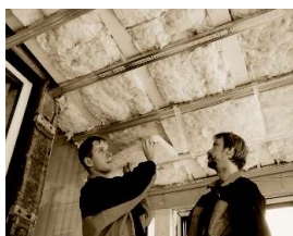
Ilustračná fotografia inštalácie fólie ECOFILM C na kovové nosníky
