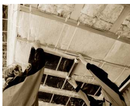
Ilustračná fotografia inštalácie fólie ECOFILM C na kovové nosníky
