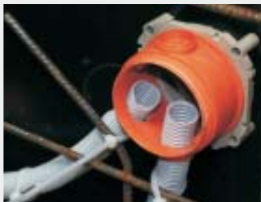
Namontované ohebné trubky do tělesa KBT.
