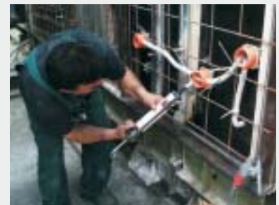
Utěsnění prostupů (tmel).
