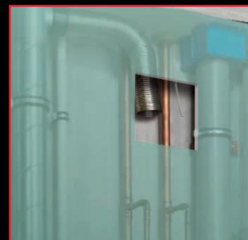
Adapter (ELS-VA, Zubehör) auf das Gehäuse aufschrauben. Flexrohr mit dem Ausblasstutzen verbinden, Elektro-Anschluss herstellen, Gehäuse mit aufgesetztem Adapter von der Raumseite aus einschieben und mit der Beplankung verschrauben. Fertig!
