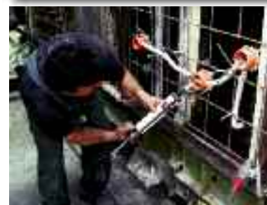
Utěsnění vstupů (tmel).
