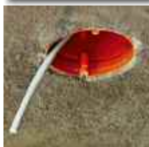
Krabice KBT... s vyvedeným vodičem připravená pro montáž lustrháku KBP...
