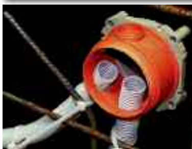
Namontované ohebné trubky do tělesa KBT.
